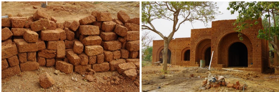
Fig. 16 : BLT et construction en BLT, Bukina Faso (Source : photos personnelles)
