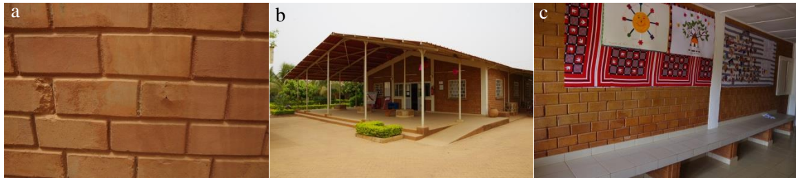
Fig. 55 : Maison de Fatí, Ouagadougou (Source : photos personnelles)
