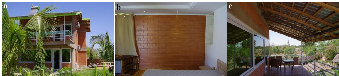
Fig. 53 : Lagon Lodge Hotel, Loumbila (Source : photos personnelles)
