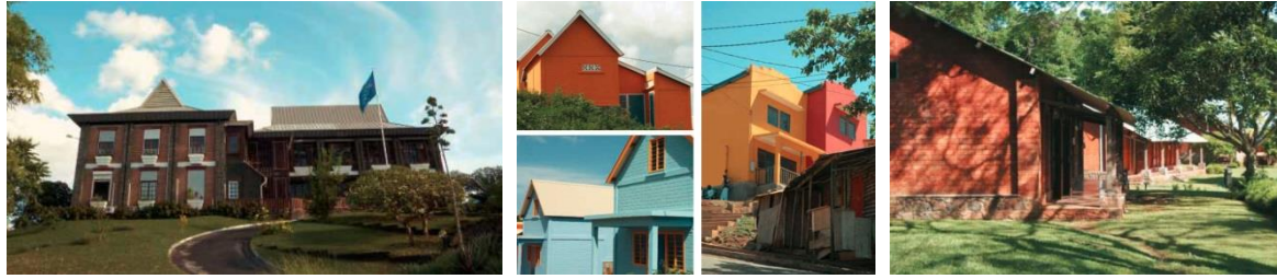
Fig. 24 : Constructions en BTC à Mayotte : Préfecture ; Logements sociaux, Ecole (Source : craterre.org)
