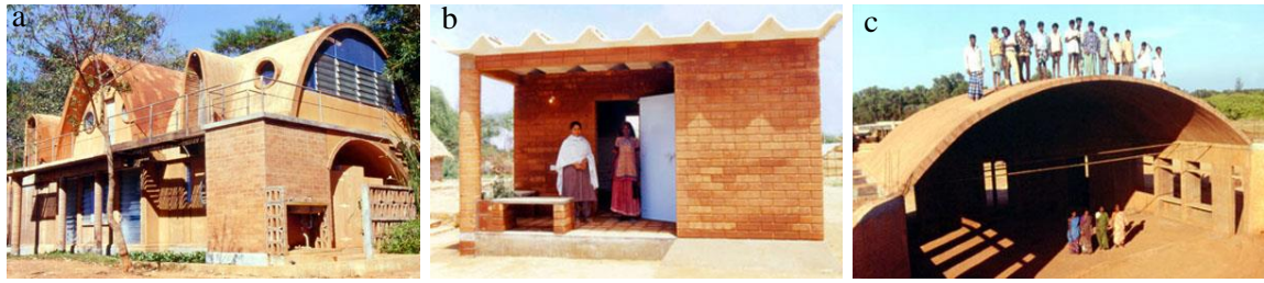
Fig. 36 : Auroville Earth Institute : Training Center ; Aum House construite en 62h à Gujarat ; Deepanam School (Source : Auroville Earth Institute)
