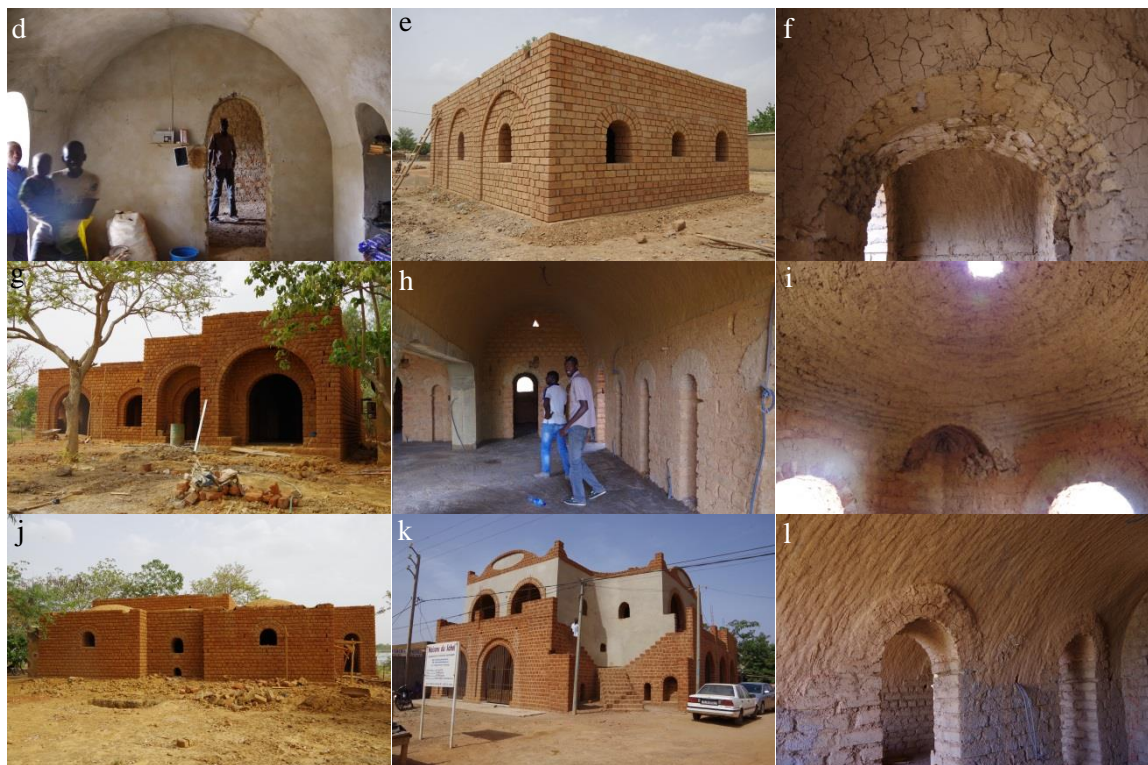
Fig. 57 : Chantiers Voûtes Nubiennes (Source : photos personnelles)
